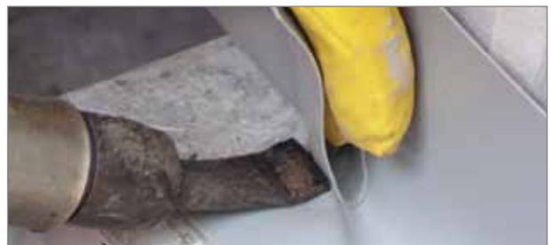
▲ 4. Verbinden der Dichtelemente durch Schweißen
